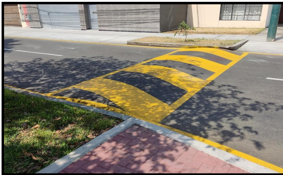
FOTO N° 03 PINTURA EN GIBAS
