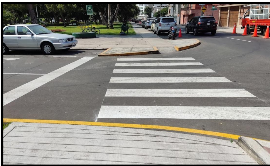
FOTO N° 04 PINTURA EN CALLES
