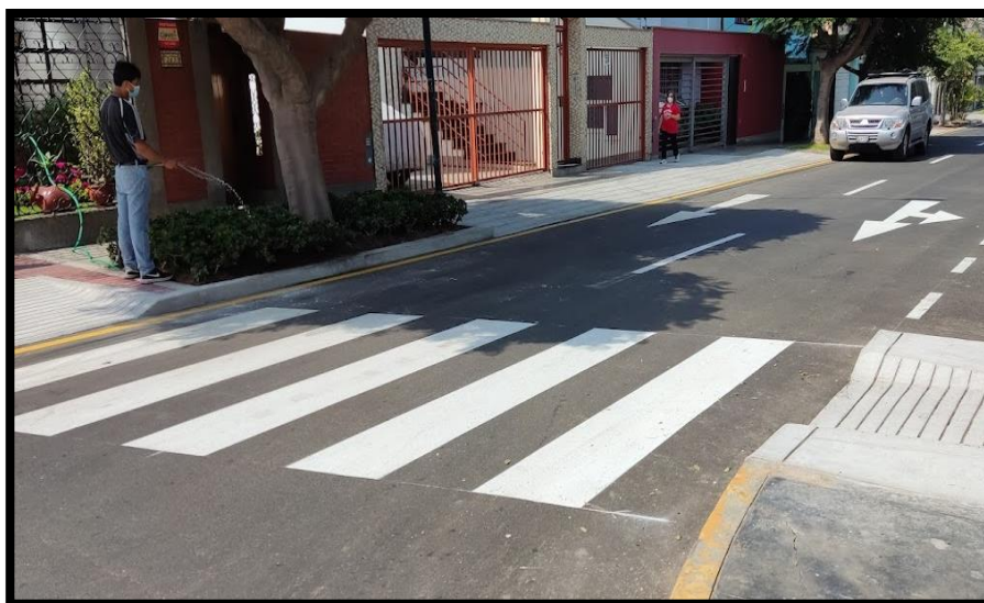
FOTO N° 05 PINTURA EN CALLES
