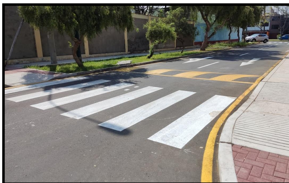
FOTO N° 02 PINTURA EN CALLES Y GIBAS
