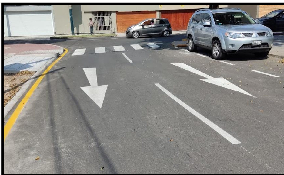
FOTO N° 01 PINTURA EN CALLES
