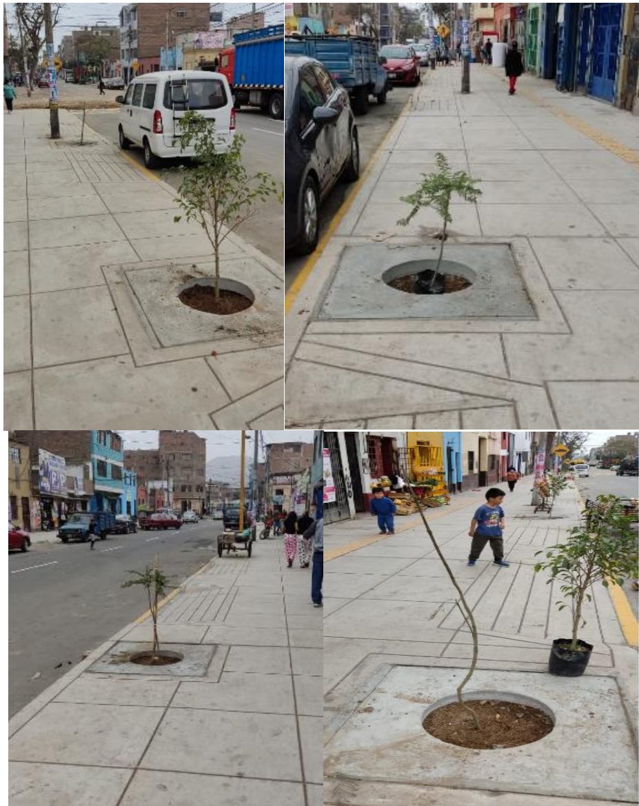
VISTA DONDE SE APRECIA LOS TRABAJOS DE PAISAJISMO
