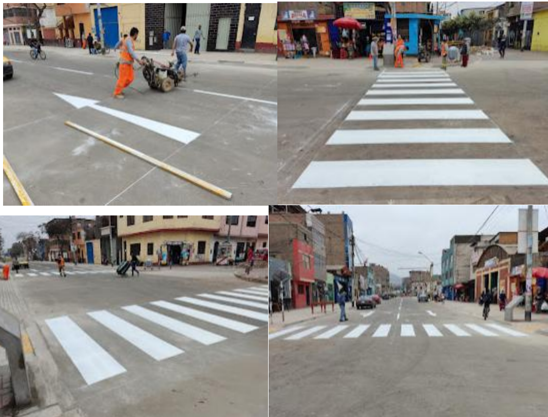
VISTA DONDE SE APRECIA LA SEÑALIZACIÓN HORIZONTAL
